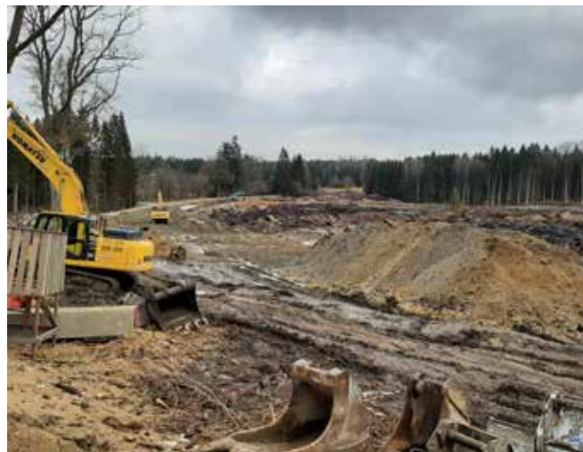
Abb. 12: Bagger beim Teichneubau des Josefsthälerteichs. Der Bagger am hinteren Ende des Teichs in der Mitte des Fotos gibt einen Eindruck davon, wie groß der Teich ist.
