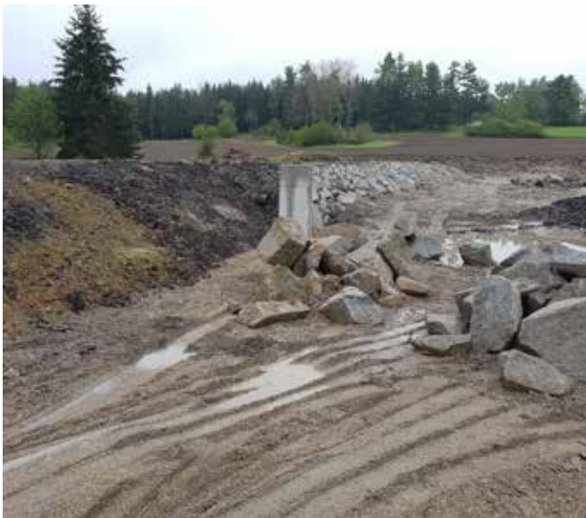
Abb. 54: Neuanlage eines Teichs bei Heidenreichstein im Waldviertel. Zu sehen sind der Dammaufbau, Mönch und Erdmassen.
